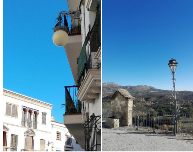
Alumbrado público exterior poco eficiente
